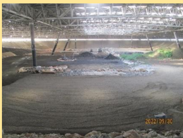
「エコアくまもと」 覆蓋施設埋立状況 (令和4年9月30日)
