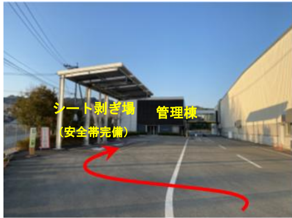
(順路⑦) 荷台シート剥ぎ等の作業は所定の場所で行います。 転落防止のため、安全带をご使用ください。
