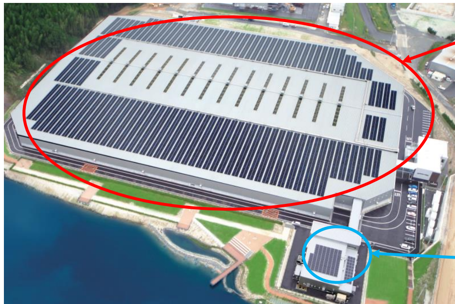
覆蓋施設 (埋立地)
