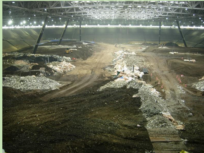
「エコアくまもと」 覆盖施設の埋立状況
