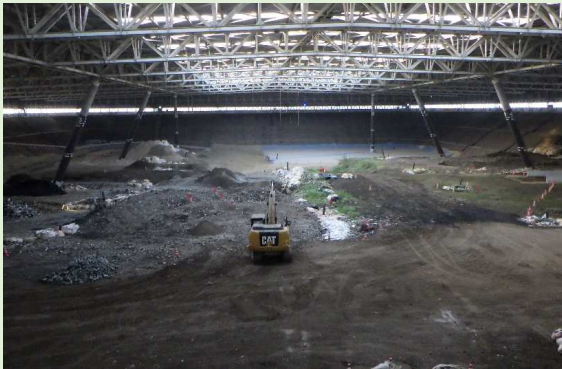
「エコアくまもと」 覆蓋施設の埋立状況 (令和元年9月2日)
