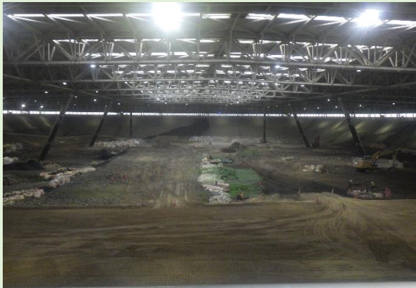
「エコアくまもと」 覆蓋施設の埋立状況 (令和2年8月31日)
