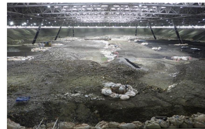
「エコアくまもと」 覆蓋施設の埋立状況 (令和3年2月26日)
