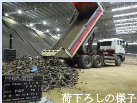
荷下ろしの様子
