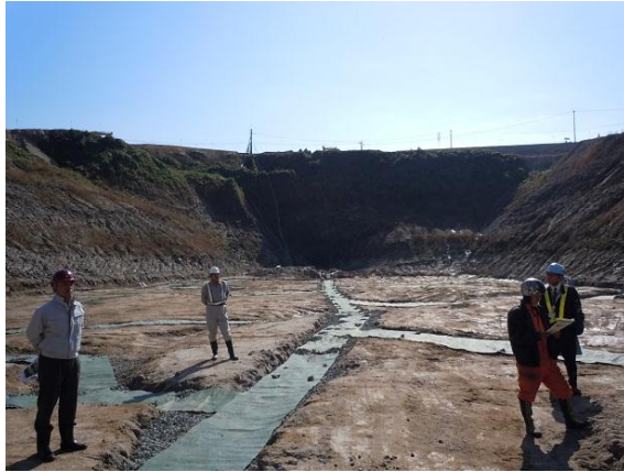
【素掘の側溝の様子】
