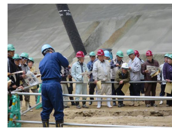
【地下水集排水管施工箇所の確認】
